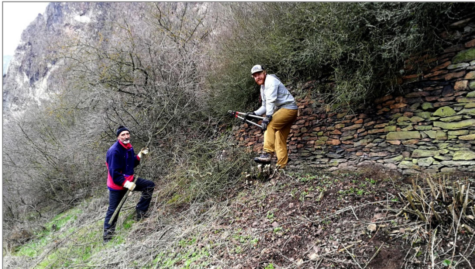
Christian und Simon im Einsatz an einer zugewachsenen und überwucherten Weinbergsmauer
