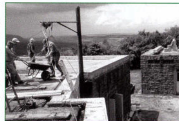
In unzähligen Arbeitsstunden wurden die Gebäude renoviert.
